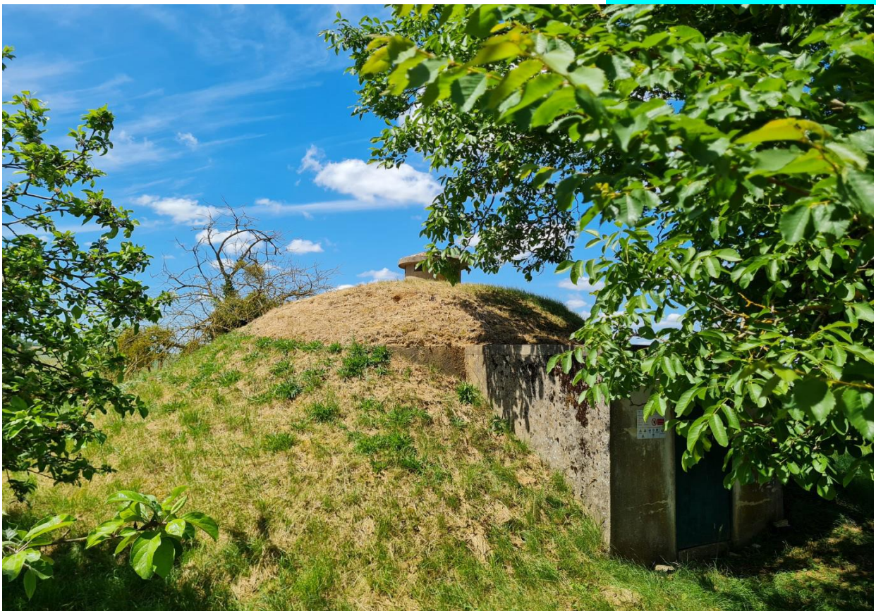
Photo du château d'eau semi-enterré
